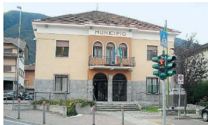
Ultimo baluardo. Il municipio di Berzo Inferiore
