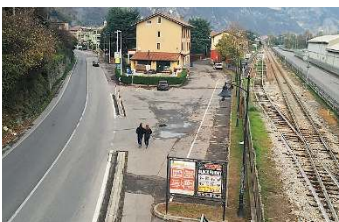
Il piazzale. Cantieri ai blocchi di partenza nel piazzale della stazione
