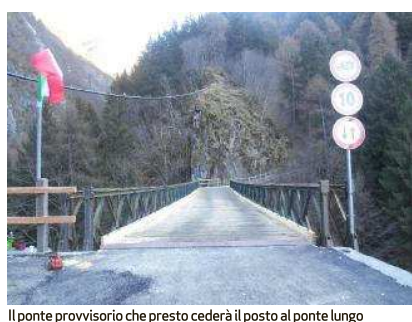
Il ponte provvisorio che presto cederà il posto al ponte lungo
