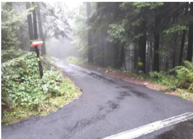
Lavori di asfaltatura sulla rete viabilistica di Gianico
