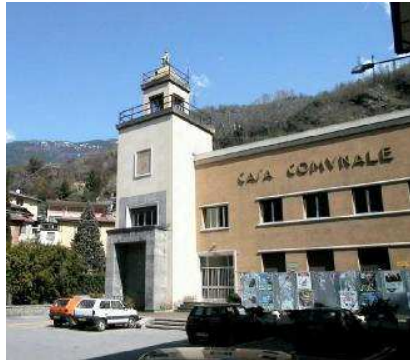
Alta tensione nel palazzo comunale di Cedegolo
