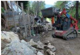
Il ripristino dei muretti abbattuti dalle slavine
