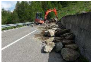
La rimozione dei sassi pericolanti lungo la strada
