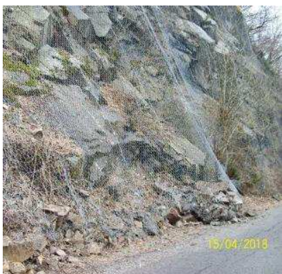
Un tratto di rete paramassi lesionata lungo l'arteria
