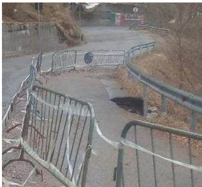
Uno dei cedimenti sulla strada tra Montecampione e il Plan
