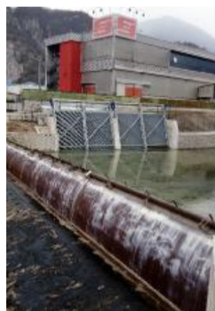
La centralina sul fiume Oglio
