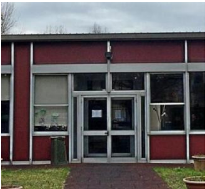
L'ingresso dell'ormai ex asilo di Darfo: il destino della struttura divide
