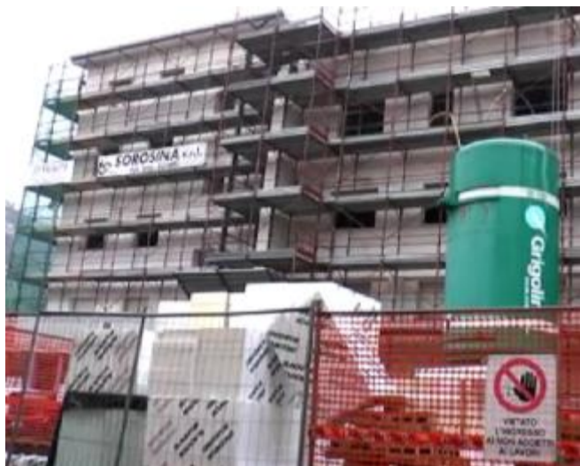
Lavori in corso nella sede della Pia fondazione di Malegno
