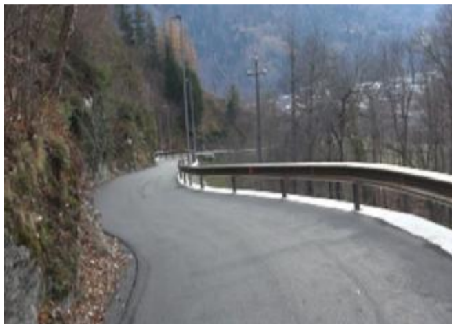
Un tratto di via Scaione di Edolo appena rimesso a nuovo
