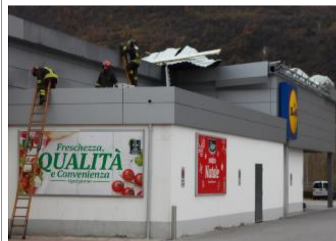
Al lavoro sul tetto del supermercato danneggiato dal vento
