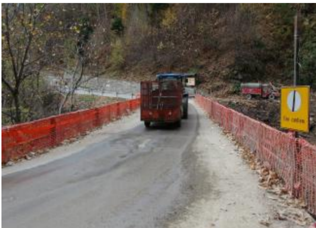
Lavori in corso sulla provinciale a Paisco Loveno
