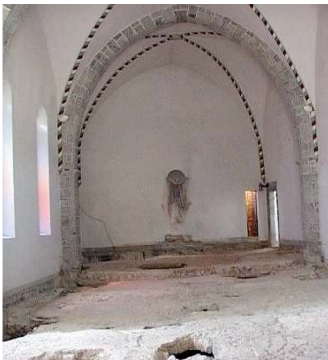
Gli interni. Lavori in corso nella chiesa dell'Eremo
