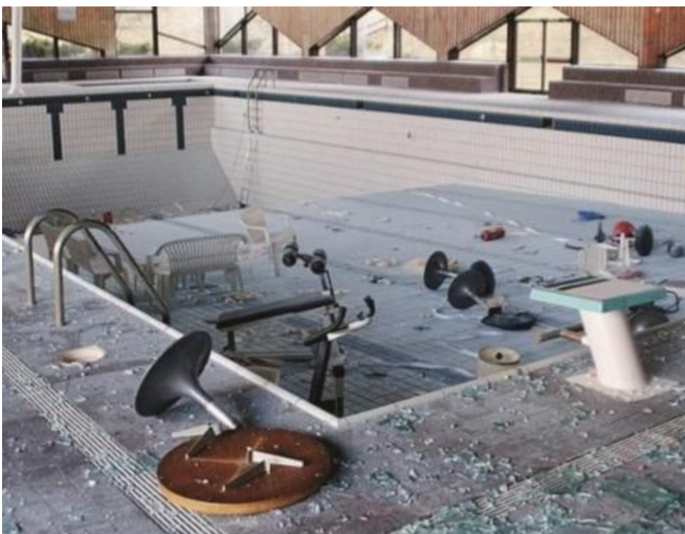
La piscina abbandonata dell'Hotel Montecampione, trasformata in una discarica
