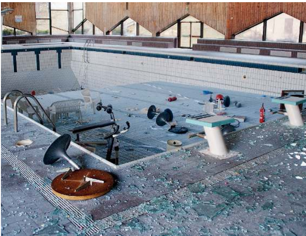
Degrado. La struttura, compresa la piscina, è stata più volte oggetto di atti vandalici
