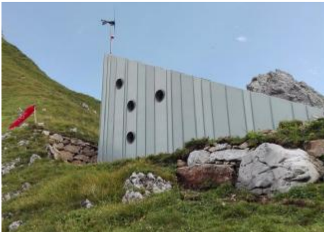
Il nuovo bivacco installato al Valzellazzo, sopra Lozio
