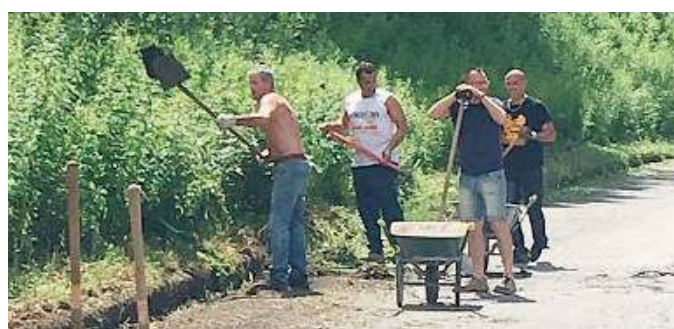
Al lavoro. Alcuni operai sistemano la strada per Plan
