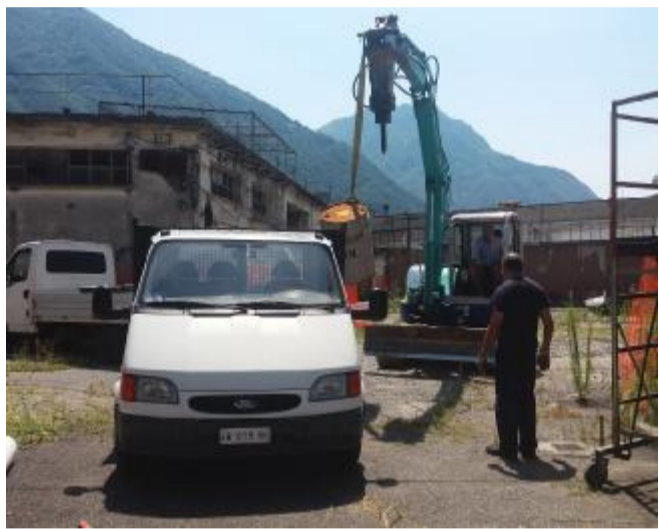
I lavori all'interno dell'area produttiva della ex Palini di Pisogne
