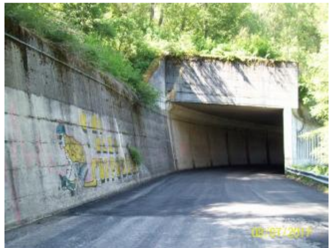
Lavori anche nella galleria sulla strada del Plan di Montecampione
