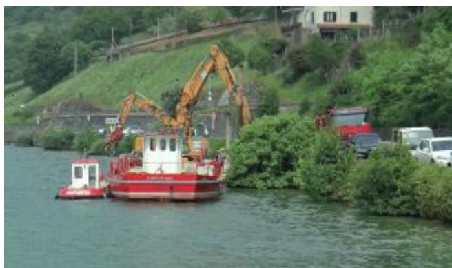
Primo collaudi sui punti in cui infilare i pali della passerella
