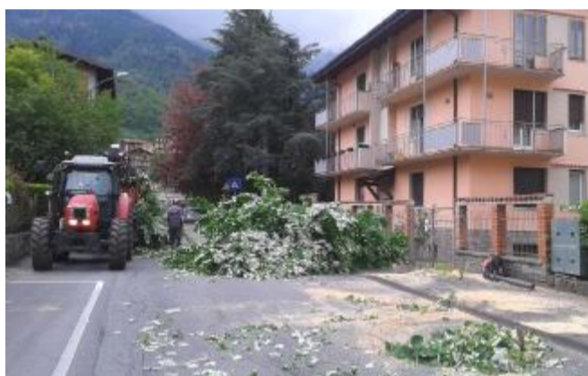
Lavori preliminari avviati nella zona di via Gelpi a Edolo
