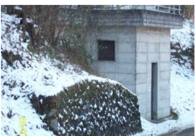
Una delle vasche di accumulo dell'acquedotto di Artogne
