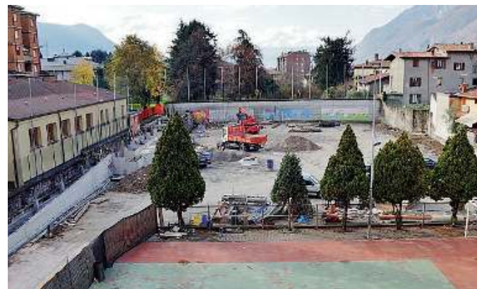
Cantieri. Una veduta dell'oratorio «San Filippo», già finito «sotto i ferri»
