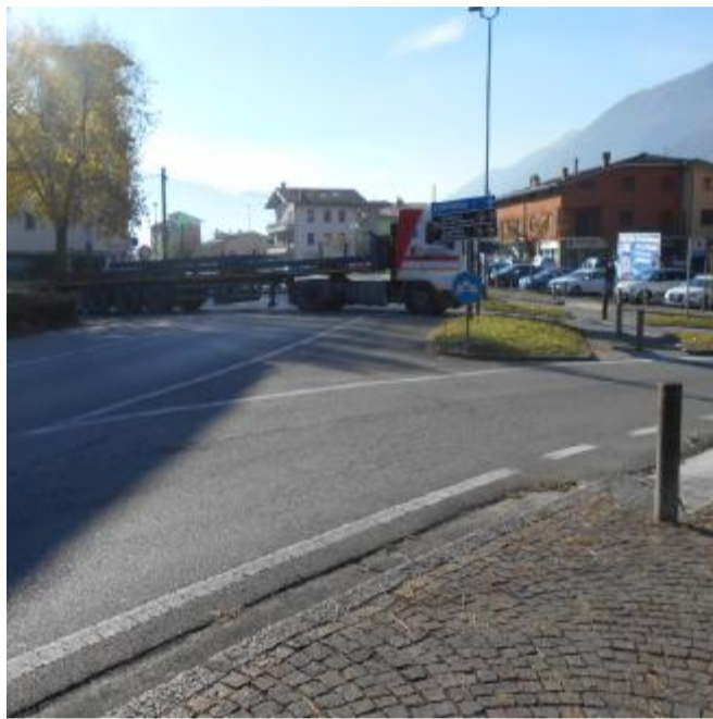
Ceto: uno scorcio dell'intersezione che sarà rimpiazzata dal rondò
