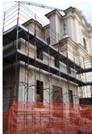
Il cantiere per il nuovo teatro
